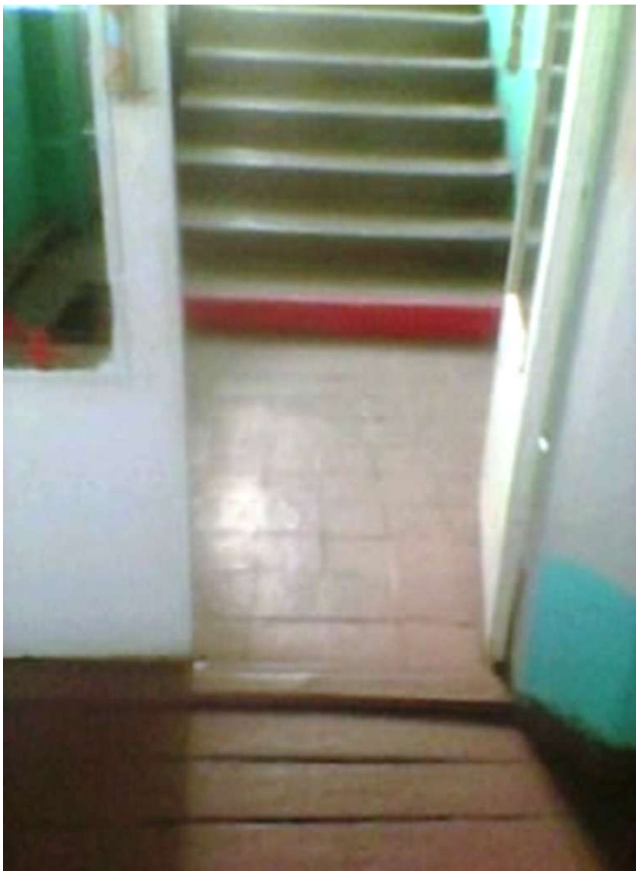
№ 15. Лестничная площадка 1 этажа
